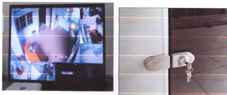
Gambar 27 Sistem pengaman akses ke ruang data center
