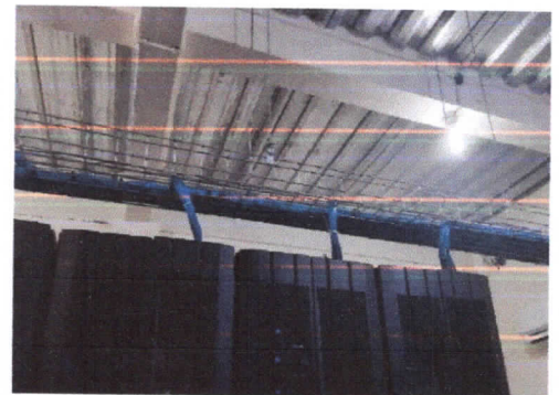
Gambar 24 Kabel tray untuk Jalur Kabel Data antar Rack
