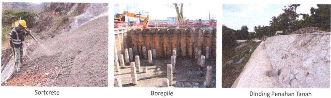
Gambar 6.2 Mitigasi untuk menghindari kondisi longsor di Kabupaten Cirebon
